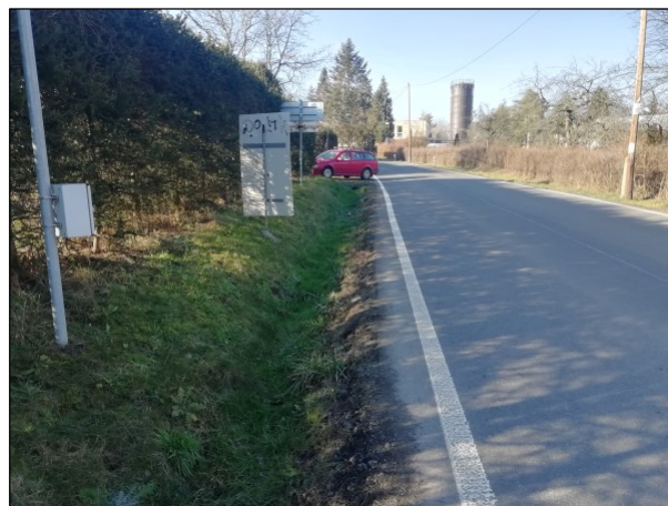
Měřený profil silnice II/104, sm. Petrov, Davle
