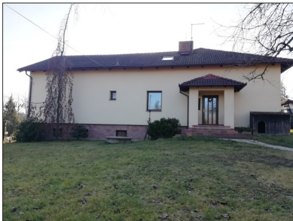
Bod 1 – měřený objekt, Jílové u Prahy 525
