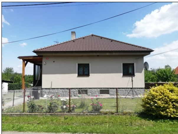
Bod 5 – měřený objekt, Netvořice, Dunávice 25
