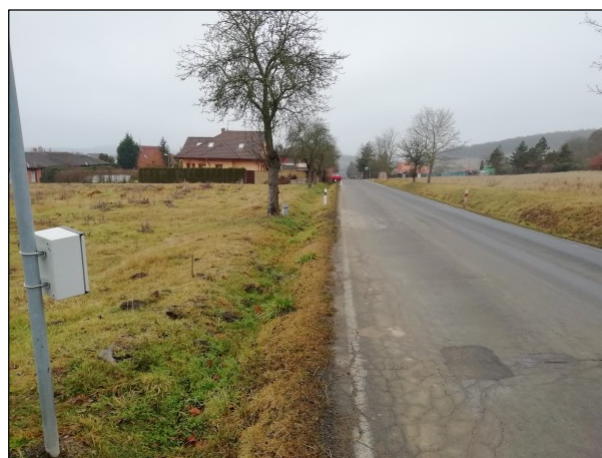
Měřený profil silnice II/104, sm. Petrov, Davle
